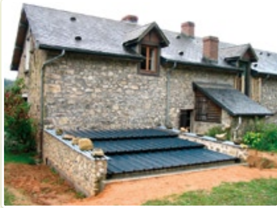
Toit coulissant du silo de stockage
