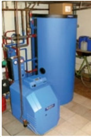
Ballon de stockage et chaudière
