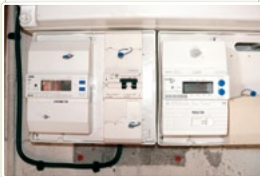
Compteurs de consommation (à gauche) et de production (à droite)
