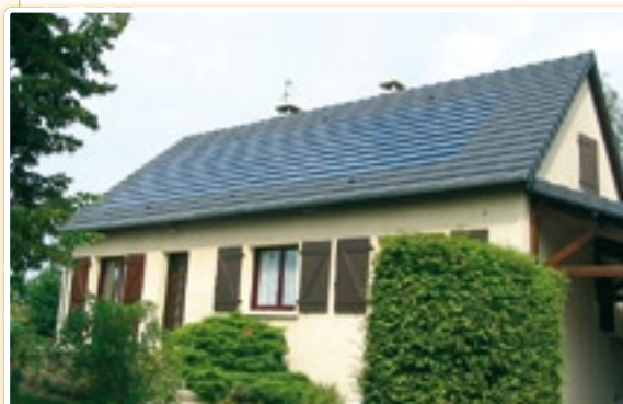
Saint-Symphorien-de-Marmagne (71) / Modules intégrés en toiture
