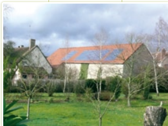
La grange et sa toiture solaire
