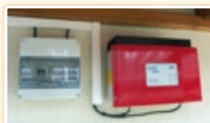
Onduleur de couplage réseau
